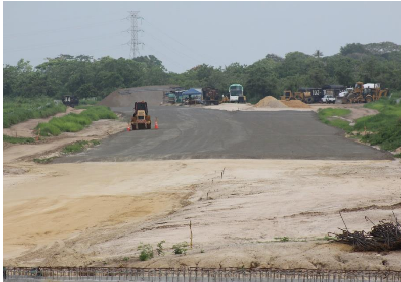
Construcción obras de drenaje-Box culvert
