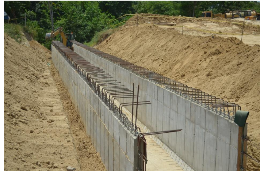
Construcción obras de drenaje-Box culvert
