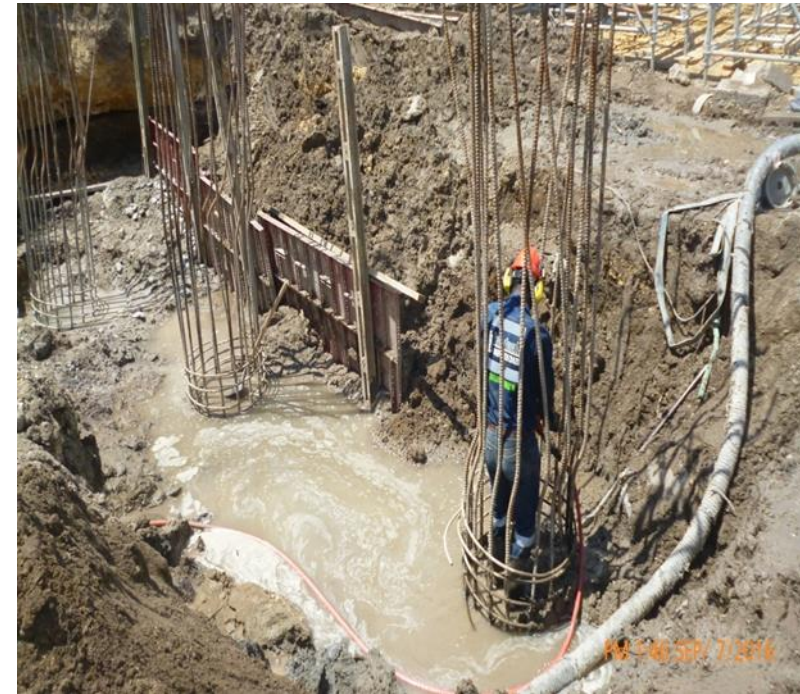
Demolición de parte superior pilotes estribo 1
