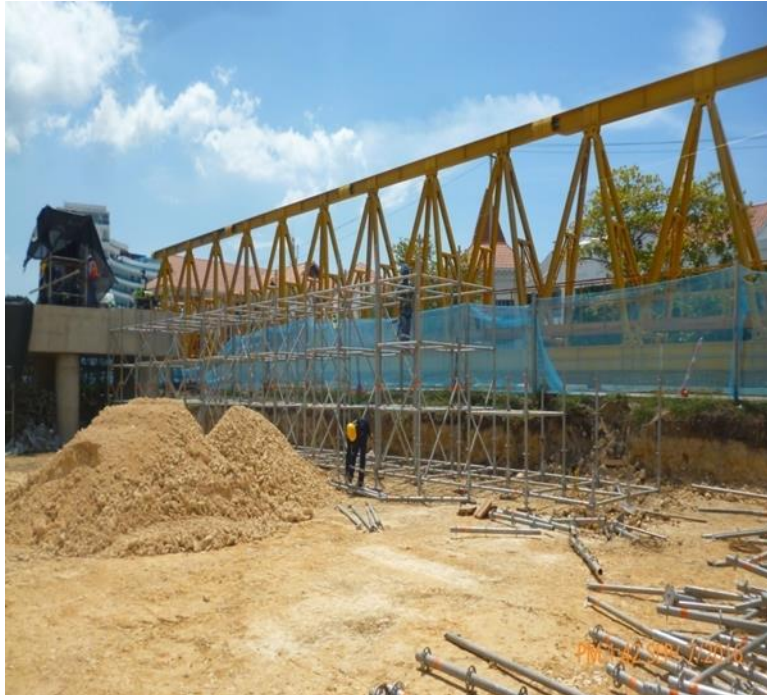
Montaje de estructura falsa puente cielo mar
