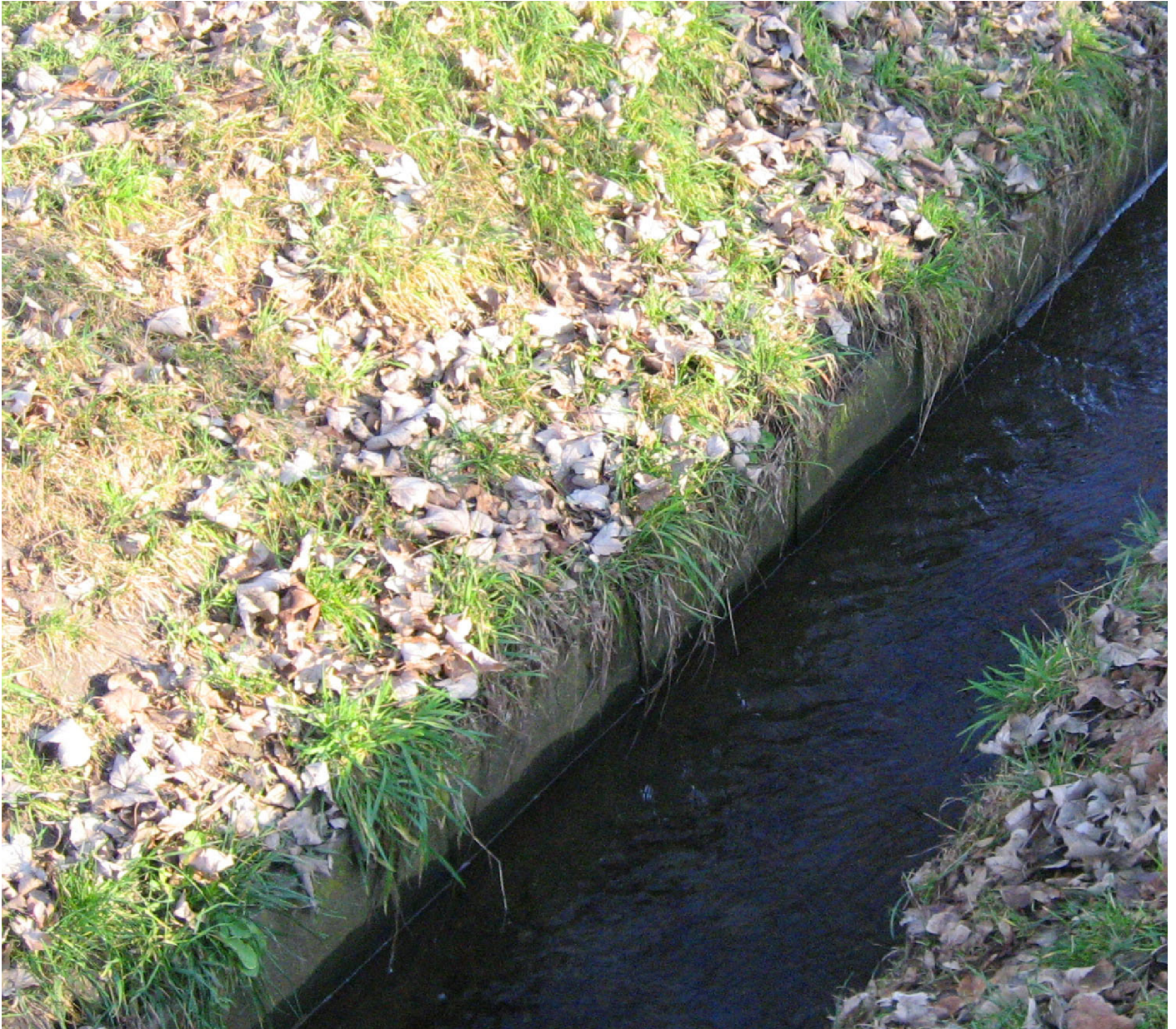
Kappgraben, aktuelle Sohlbefestigung
