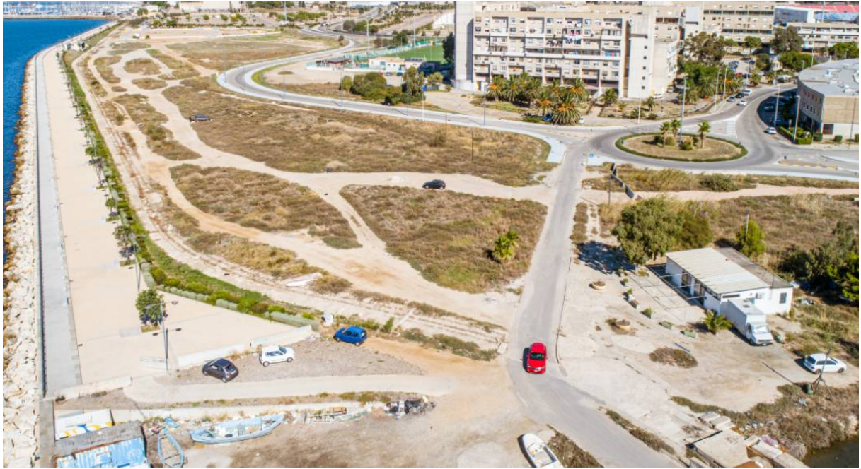
Fig.4: Vista dell'area verso L'arena grandi eventi – le interferenze superficiali, oleodotto
