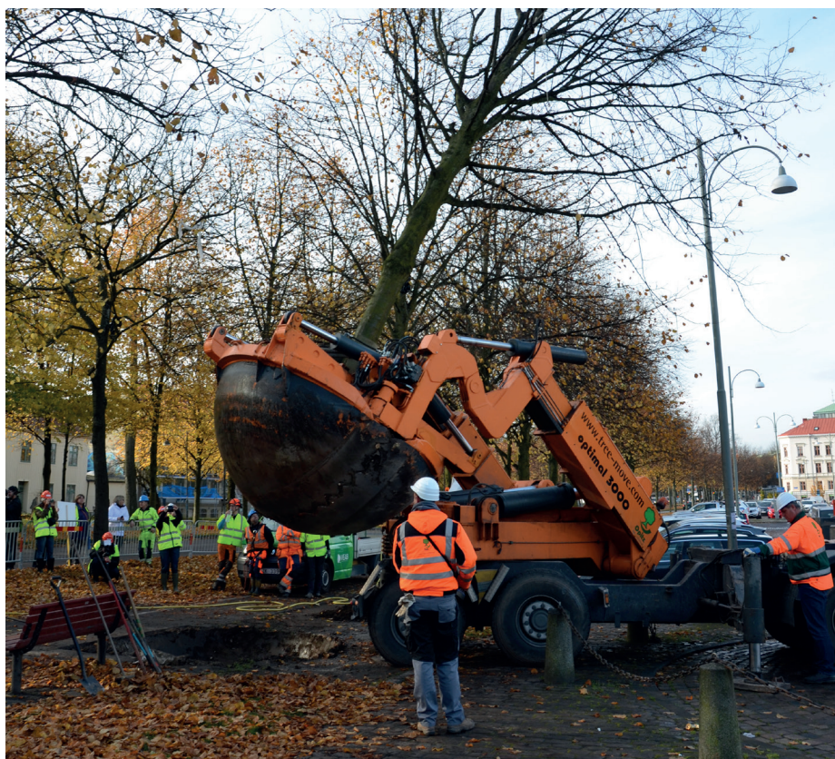
Provlyft av lind ( Tilia x europea ) i Nya Allén som förberedning inför flytt av träd för genomförandet av Västlänken.
