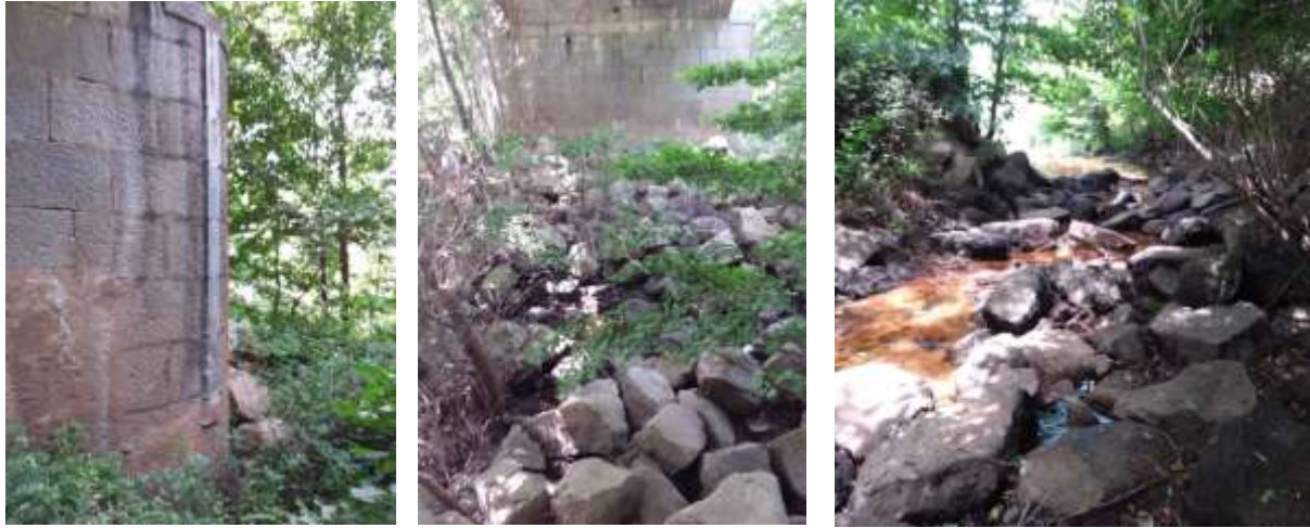
Figura 7 - Asta idrometrica e fondo alveo in corrispondenza delle pile di uno degli attraversamenti da mantenere (in foto Ponte Liscia). La presenza degli arbusti costituisce ostacolo per il funzionamento dei sensori di livello installati alla quota dell'impalcato.
