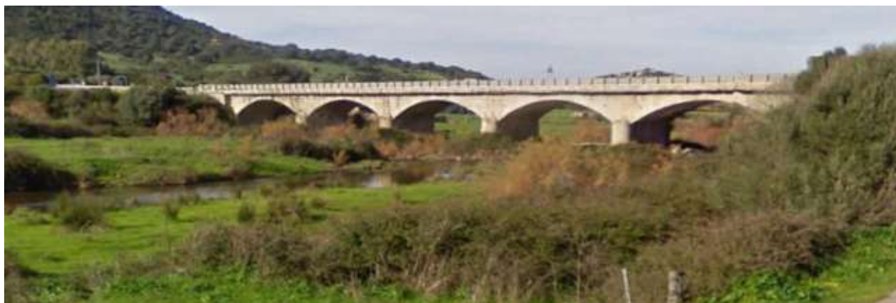
Figura 1 – Esempi di struttura di attraversamento ospitante (in foto Ponte Liscia)
