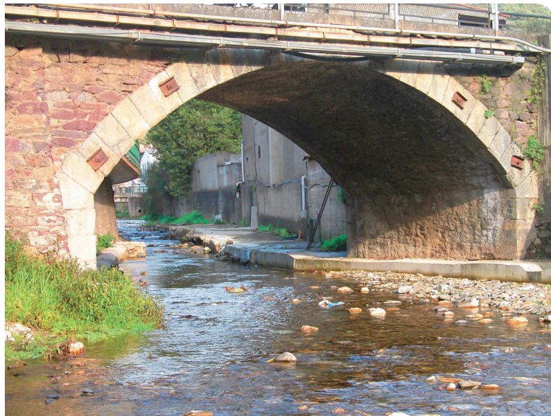
Figura 8-10 Vista del ponte da consolidare
