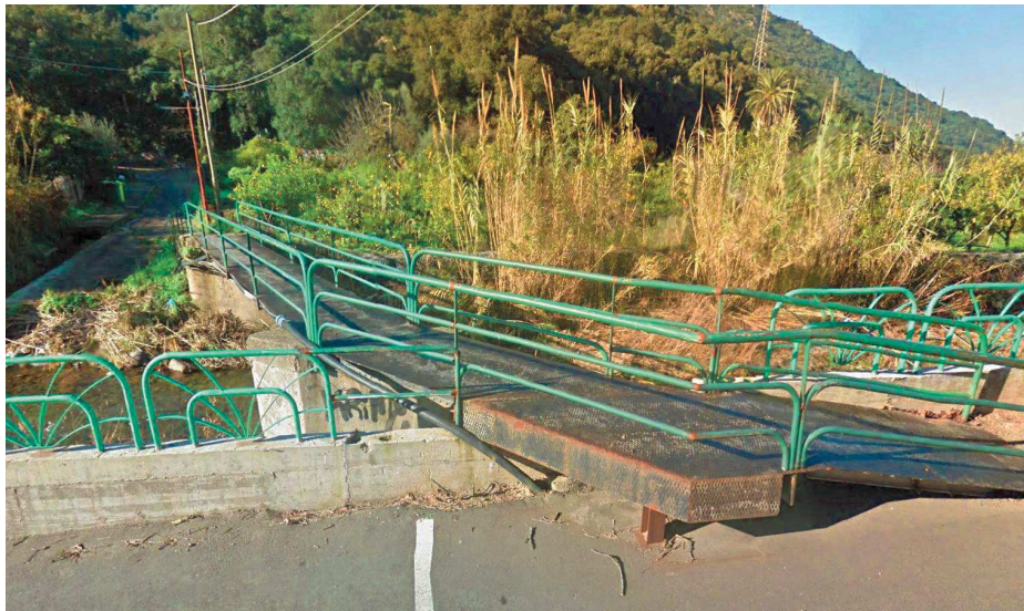
Figura 8-17 Passerella pedonale da demolire
