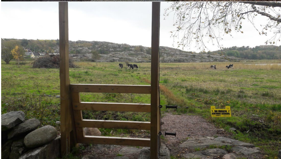
Myggstads-entren efter restaurering, augusti 2021. OBS sumphålet torrlagt!
