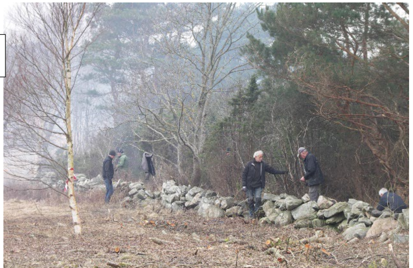
De gamla stenmurarna blev synliga igen och behövde också restaureras
