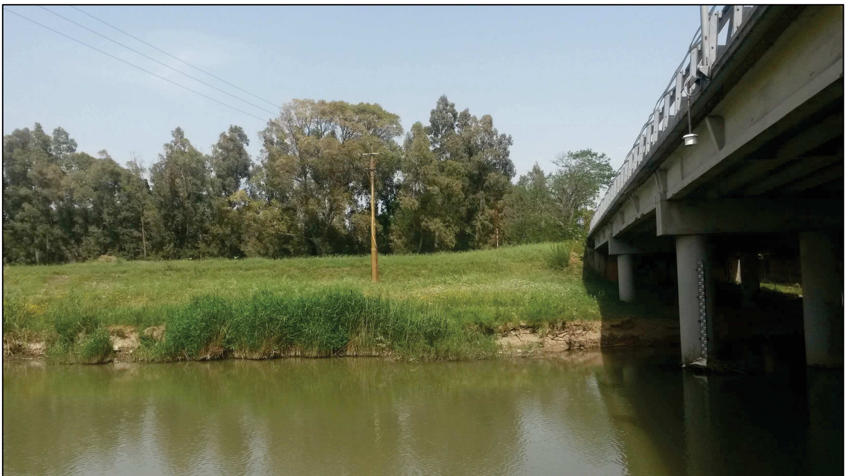
Figura 3.4 – Ponte SS 130 in corrispondenza dell'argine sinistro del Fluminimannu
