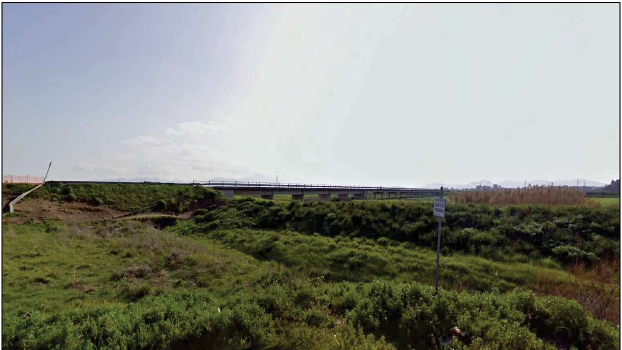
Figura 3.2 – Ponte Benetti a Decimoputzu
