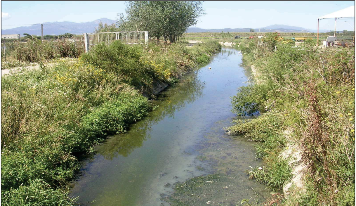
Figura 6.31 – Canale secondario sponda sinistra Fluminimannu lato Assemini
