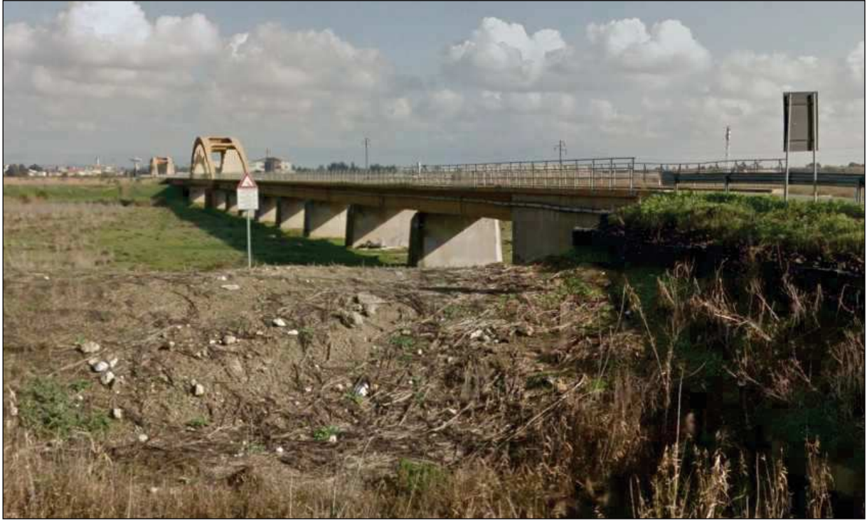
Figura 3.7 – Ponte Via Coghe
