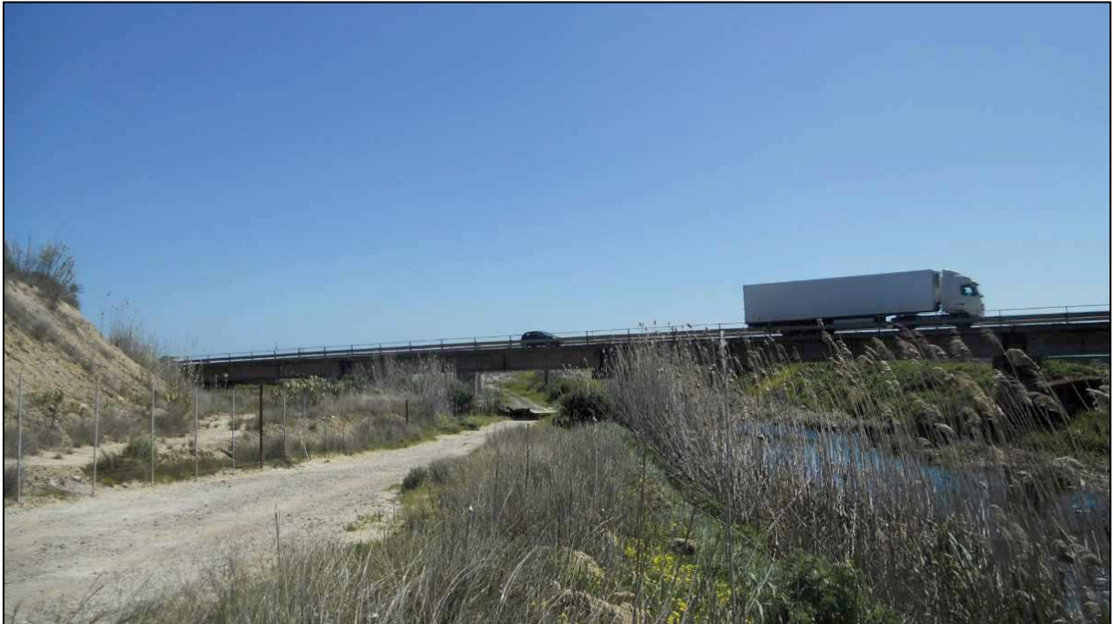
Figura 6.13 – Colatore sinistro in prossimità della SP2.
