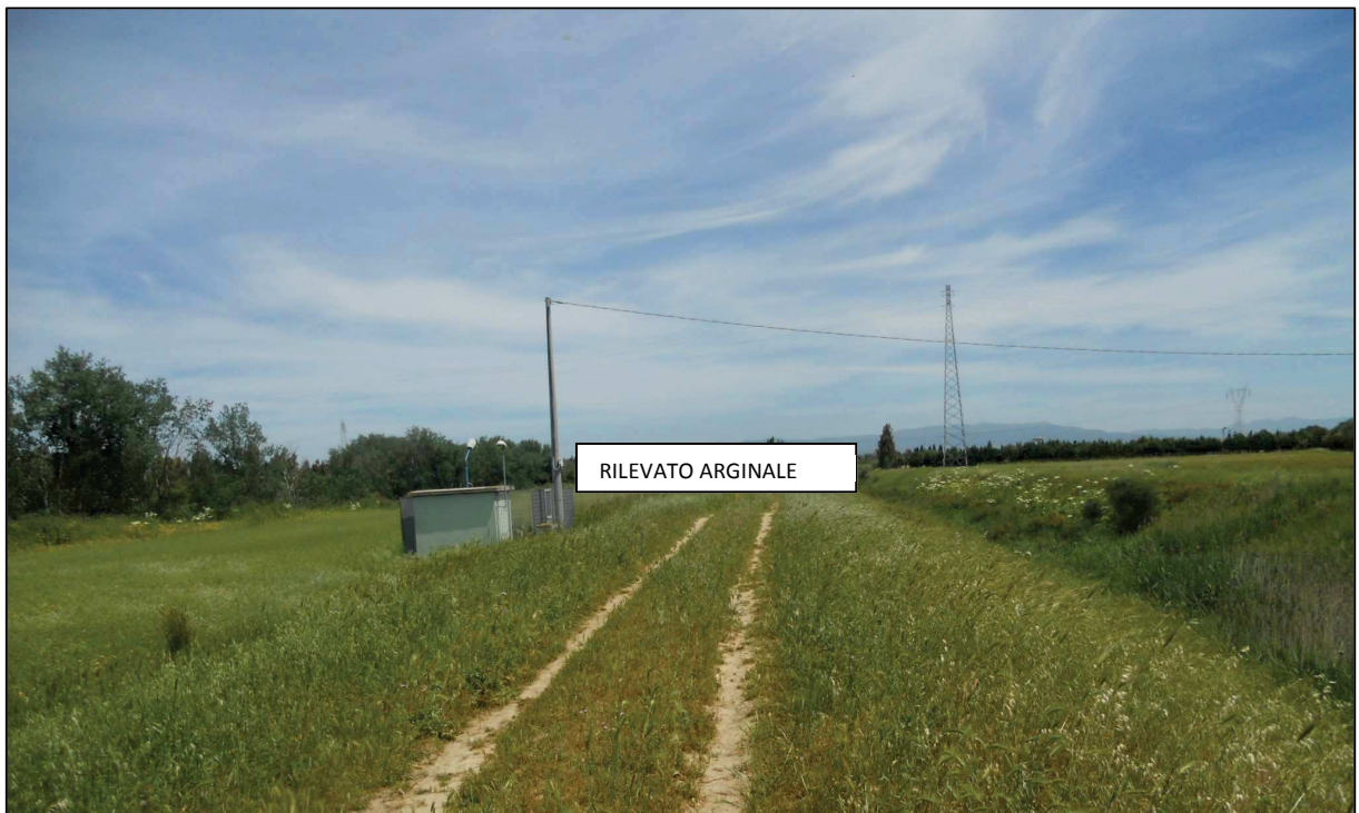
Figura 6.3 – Rilevato arginale destro subito a valle del ponte ferroviario
