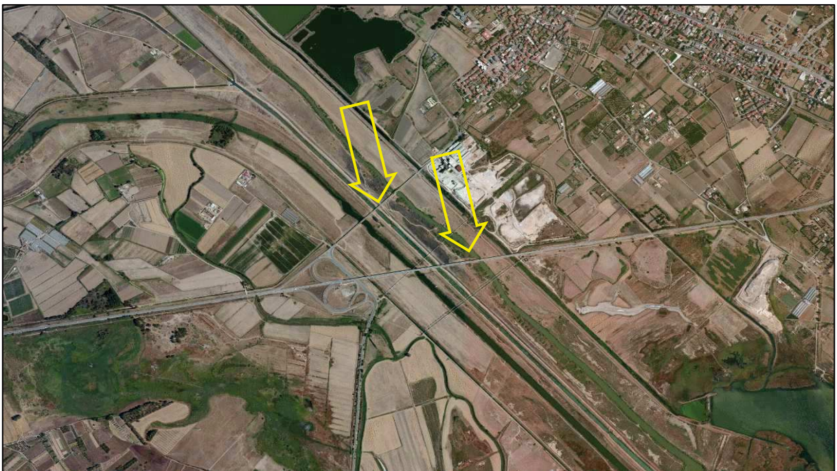
Figura 3.12 –Ponte Via Coghe – Ponte SP2
