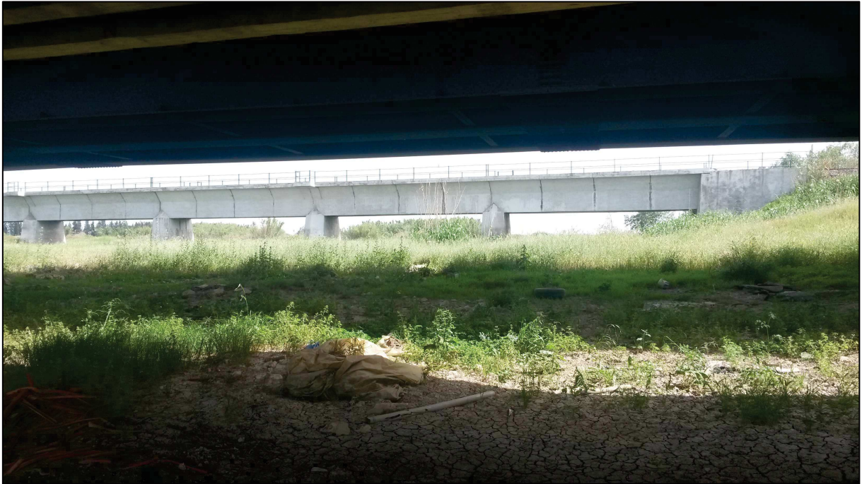
Figura 6.11 – Zone golenali con evidenti depositi tra il ponte sulla SS 130 e quello FFSS .
