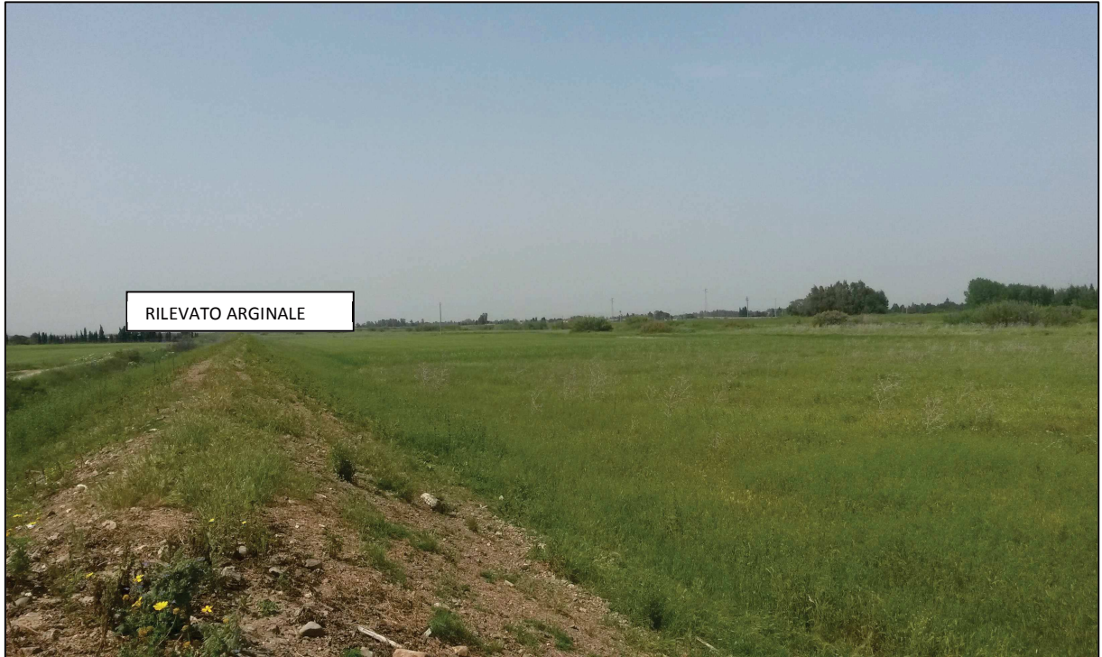
Figura 6.2 – Rilevato arginale destro prima della SS 130
