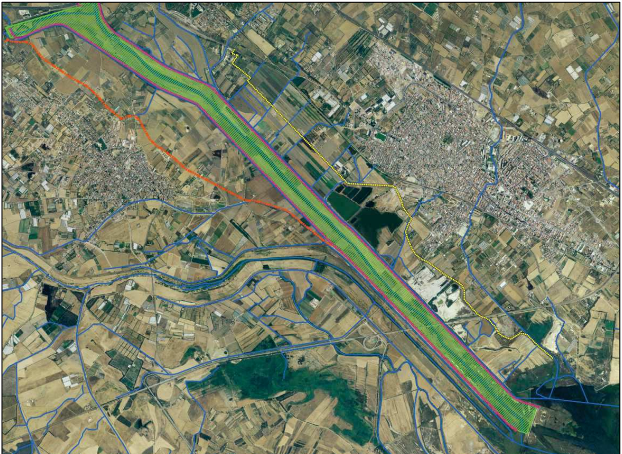
Figura 6.22 – Argini secondari lato Uta e lato Assemini – Si noti il reticolo secondario
