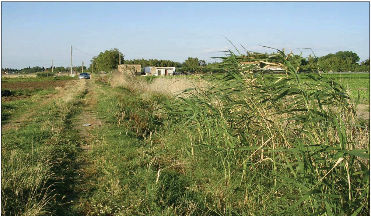
Figura 6.32 – Canale secondario sponda sinistra Fluminimannu lato Assemini
