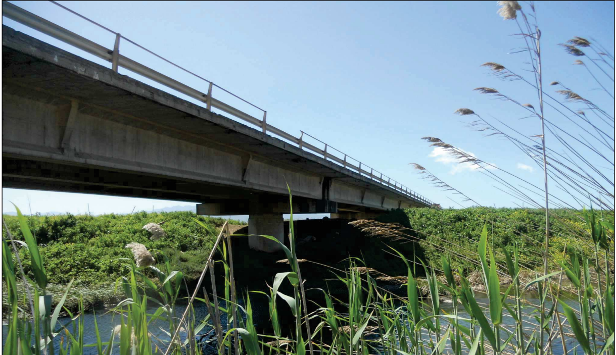
Figura 6.17 – Argine destro intestato sul ponte SP2 (coronamento a quota intradosso).
