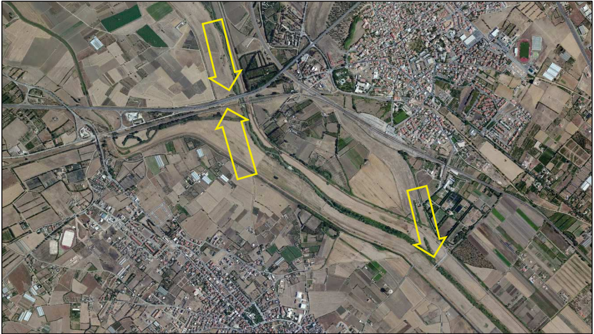
Figura 3.11 –Ponte SS 130 – ferroviario e guado forestale
