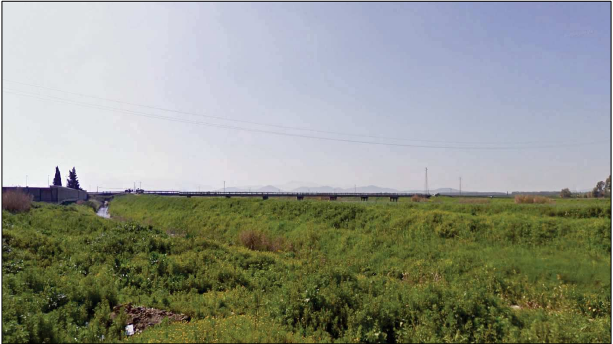
Figura 3.1 – Ponte SS 196 a Villazor
