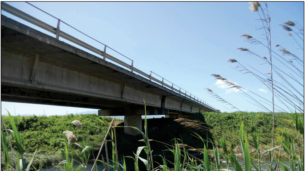
Figura 3.8 – Ponte SP2 in corrispondenza dell'argine destro del Fluminimannu
