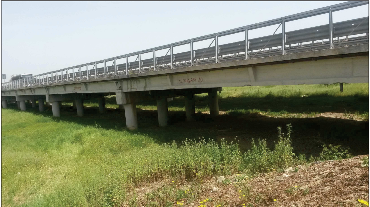
Figura 3.3 – Ponte SS 130 in corrispondenza dell'argine destro del Fluminimannu
