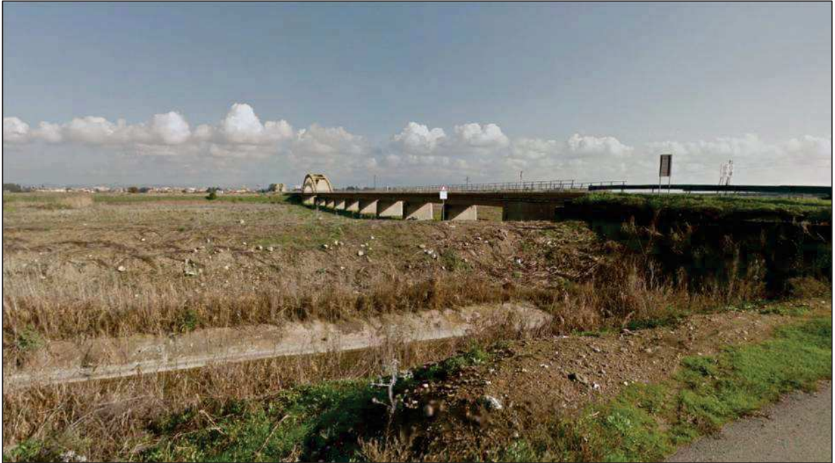
Figura 1.8 – Ponte Via Coghe in corrispondenza dell'argine destro del Riu Cixerri
