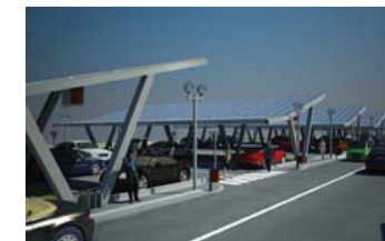
Figura 3 le pensiline fotovoltaiche
