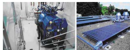
Figura 1 assorbitore a bromuro di litio monostadio e pannelli solari sottovuoto
