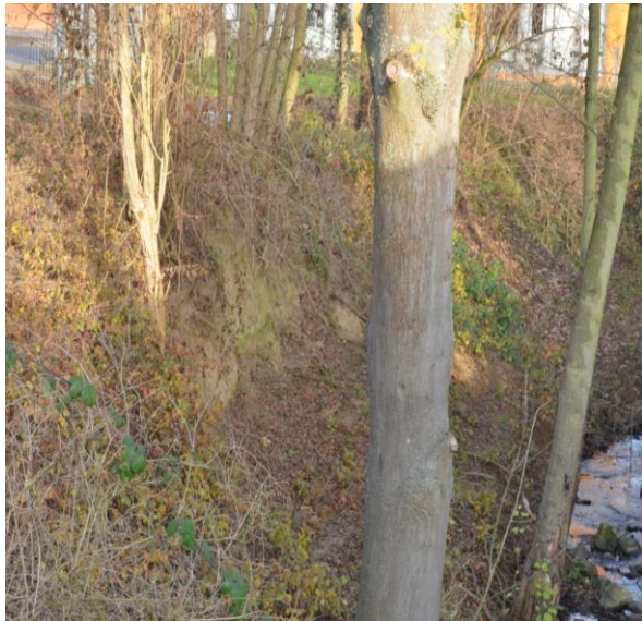
Abbildung 2: Abbruch der Böschung durch Hochwasser am Mehlemer Bach nahe der Grundschule am Mühlenpfad. (Quelle: Eigene Abbildung)
